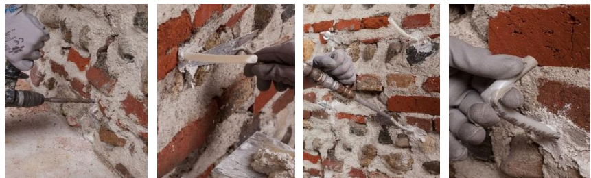
Рис. 2. Технологія ремонту та ін'єктування тріщин
