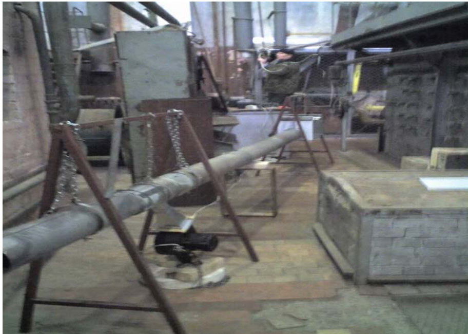
Рис. 3. Експериментальне дослідження початкової ділянки трубчастого газового нагрівача з газовим ежектором
