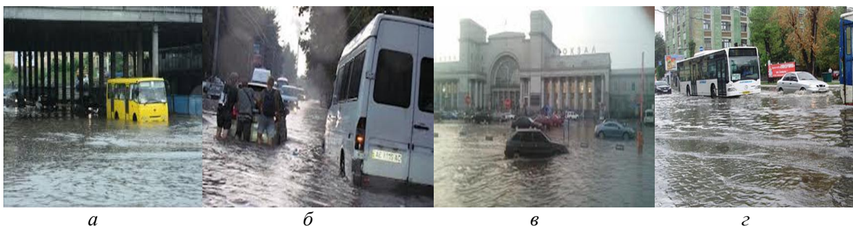
Рис. 1. Застій води на проїжджих частинах магістральних вулиць і площ загальноміського призначення м. Дніпропетровська, оснащених підземною дощовою каналізацією з системою точкових водоприймальних пристроїв: а — Набережна Леніна; б — вулиця Леніна; в — площа Петровського; з — проспект Калініна
