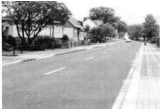
Рис. 7. Загальний вигляд лінійного водовідводу
