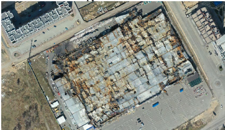
Рис. 2. Зйомка зі супутника зруйнованого даху ТЦ ЕПЦЕНТР
