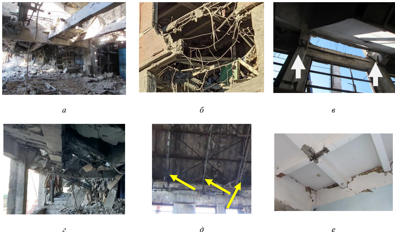
Рис. 4. Руйнування перекриття:
