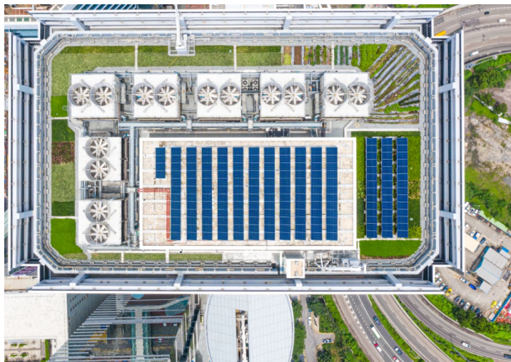
Рис. Приклад озеленення кровлі зі встановленими сонячними панелями
