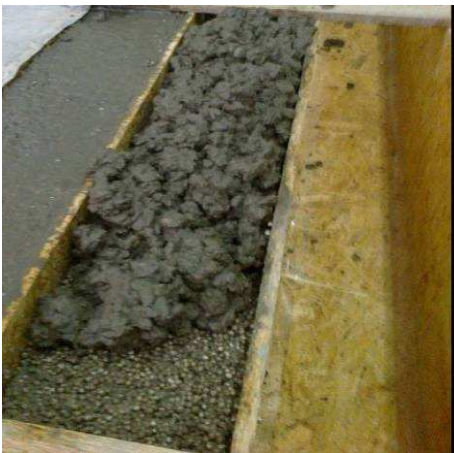
Рис.4. Процес пошарового укладання бетонних сумішей в опалубку
